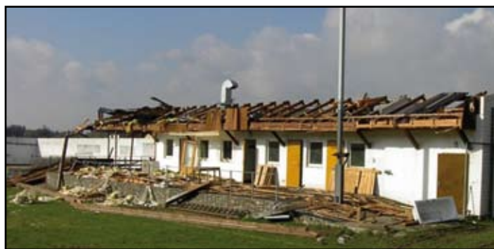
Abriss des alten Klubgebäudes
